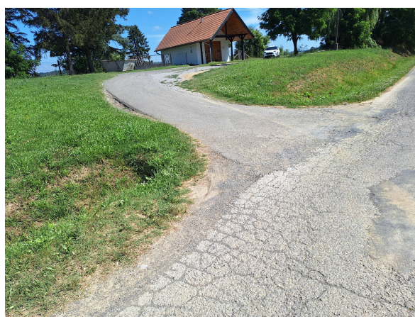
A temető útcsatlakozása
